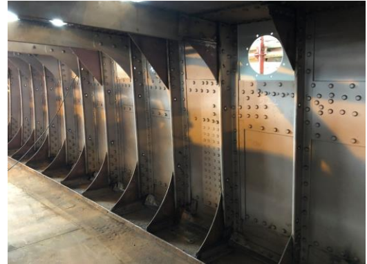
Innenwand des restaurierten Zwischendecks
