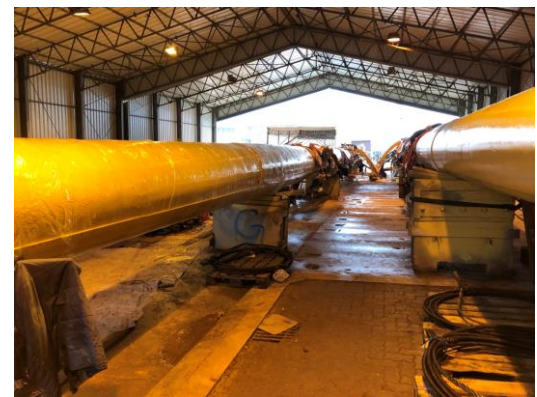
die fertig restaurierten Masten werden geriggt
