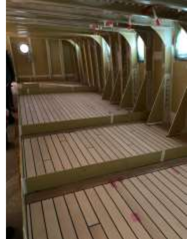
Holzdeck in den Offiziersräumen BB
