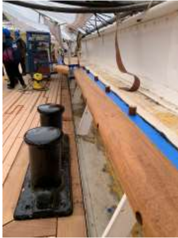
Neu verlegtes Holzdeck auf dem Hauptdeck mit in Arbeit befindlicher Nagelbank
