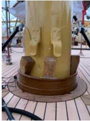
verkeilter Großmast und neues Holzdeck aus Oregon-Pine und Leibhölzern aus Kambala-Holz
