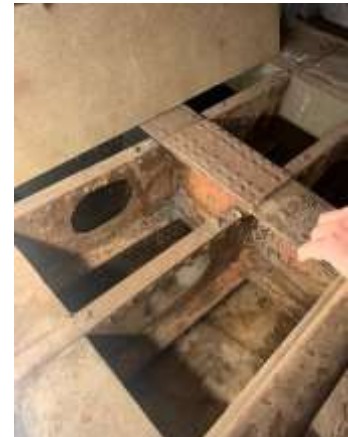
am Kielschwein freigelegte Spanten mit Blick auf die Bodenplatten
