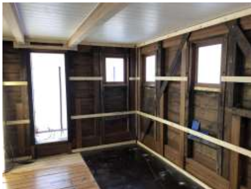
Kartenhaus innen im Rohbau
