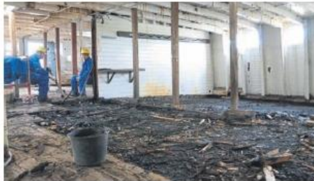
Mit Presslufthammer und Spitzhacke wird überall auf der Peking das Holz entfernt.
