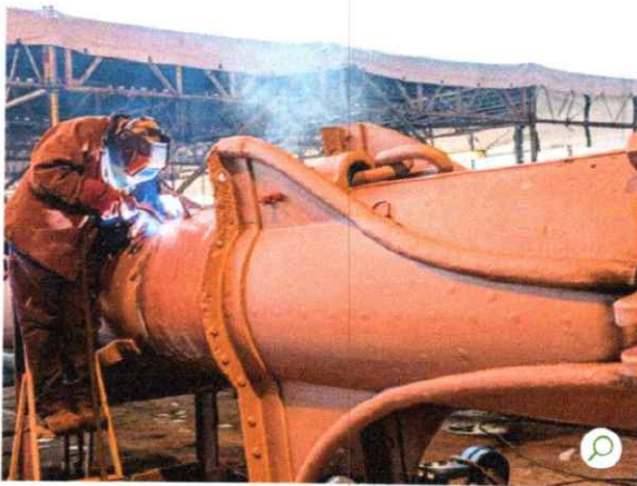
Arbeiten am sogenannten Eselshaupt an einem der Masten. Foto: Thorsten Ahlf/ Hamburger Abendblatt
